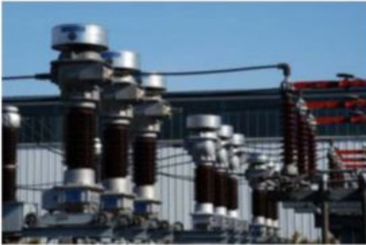
Комбинированные трансформаторы 72 кВ, Швейцария
