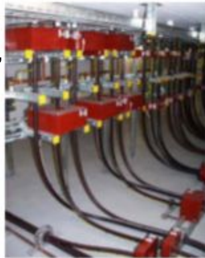
Комбинированные трансформаторы 72 кВ, Швейцария
