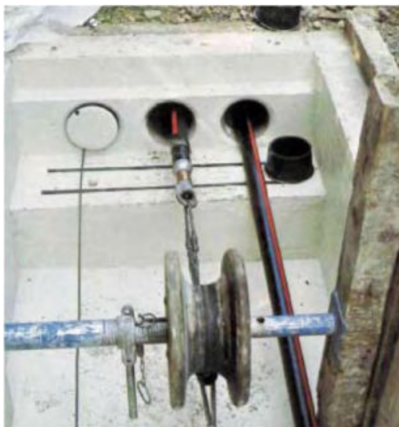
Ниша для соединения кабеля внутри трубопровода
