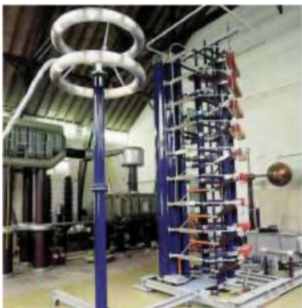
Рис. 2: Высоковольтная лаборатория в Brugg
