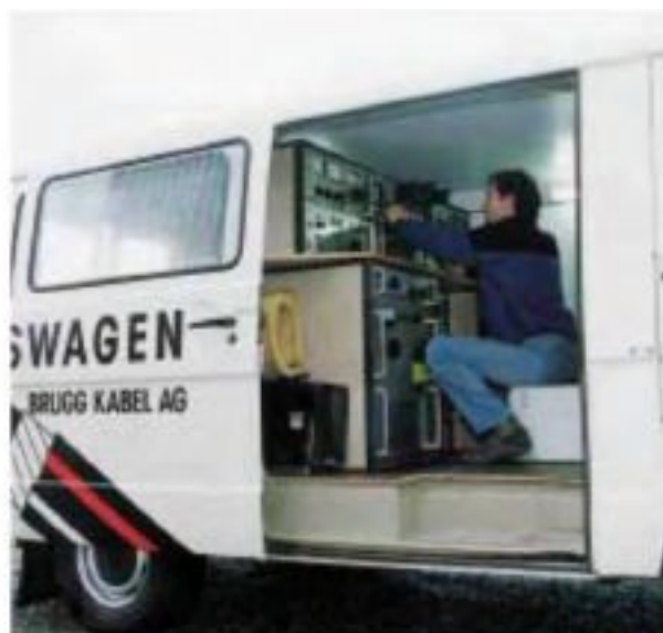
Рис. 8: Определение места повреждения кабеля
