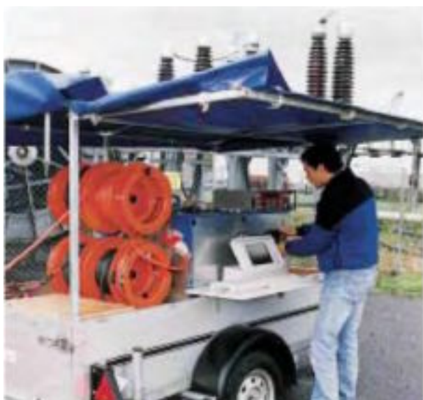
Рис. 5: Устройство для резонансных испытаний переменным током
