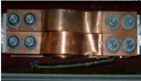
Pict. 3: Соединение высоковольтной пружины к высоковольтному контакту
