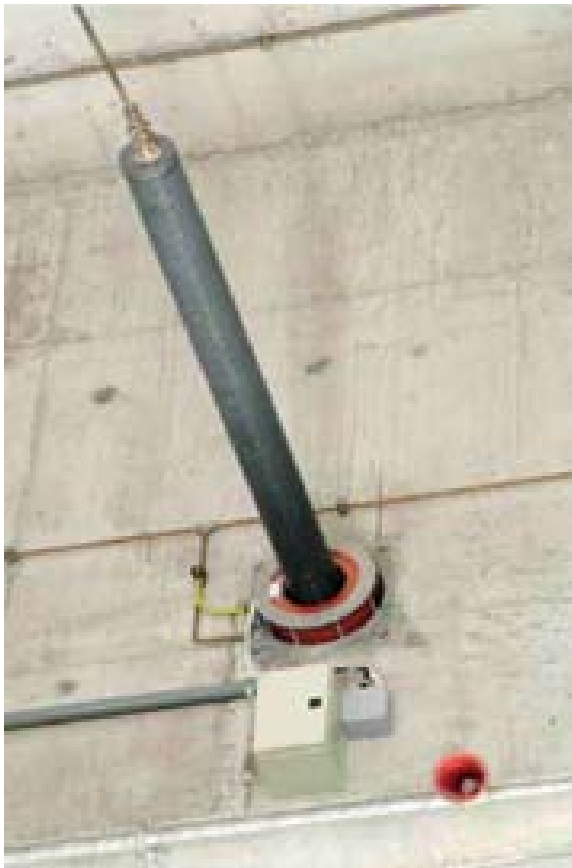
Wanddurchführung Линейный ввод Traverse murale 145 kV - 400 A HS Station von La
